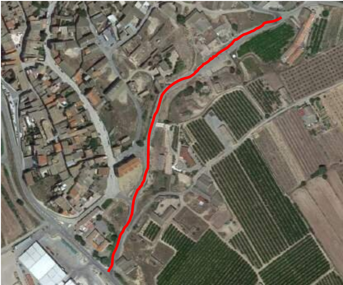
Fotografía de la zona donde se implanta el vial de circunvalación (1ª fase).
