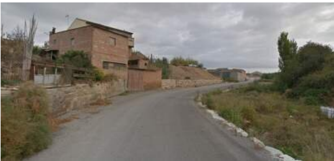
Vista del vial de circunvalación
